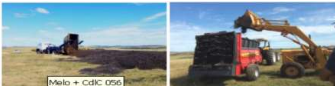
Figura 3 y Figura 4. Transporte desde PTAR y descarga en zona de acopio. Carga de estiercolera de sólidos para distribución del lodo deshidratado.
